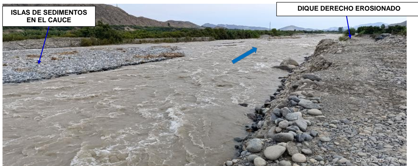
FIGURA N°03: AL FRENTE SE OBSERVA LA MARGEN IZQUIERDA DEL RIO CHANCAY-HUARAL, SECTOR SANTA ROSA CON EL DIQUE DEL CAUCE EROSIONADO Y LA MARGEN DERECHA CON EL DIQUE EROSIONADO Y POR DETRAS SE ENCUENTRAN ÁREAS DE CULTIVOS Y VIVIENDAS RÚSTICAS HABITADAS.
