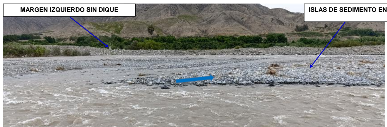
FIGURA N°02: RÍO CHANCAY-HUARAL, SECTOR BOCATOMA PALPA - HORNILLOS CON DIQUE EROSIONADO EN LA MARGEN DERECHA E ISLAS DE SEDIMENTO EN EL CAUCE DE RÍO QUE DESVIA EL CAUDAL HACIA AMBOS BORDOS..
