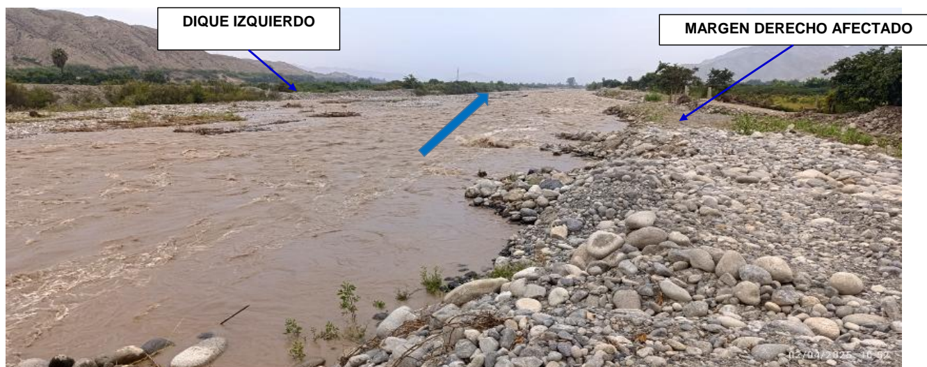
FIGURA N°04: IMAGEN PANORAMICO DEL RIO CHANCAY -HUARAL, CON DIQUES EROSIONADOS POR EL CAUDAL DEL RÍO EN AMBAS MARGENES, LADO IZQUIERDO SANTA ROSA Y LADO DERECHO HORNILLOS QUE CORRESPONDE AL TRAMO III EN PLANO.
